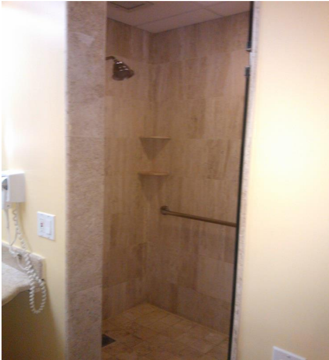
Figura 17. Regadera y sanitario con apoyos para uso de una persona con discapacidad.
