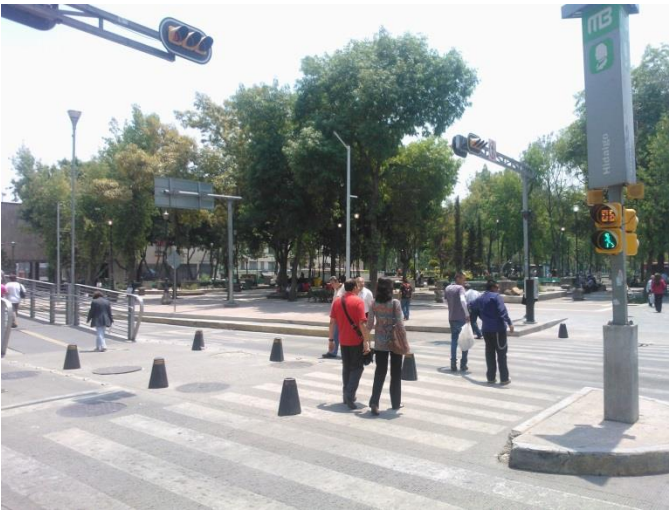
Figura 13. Cruce con diseño universal, se observan los bolardos, cruce a nivel de piso y bahía de protección.
